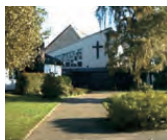
Ev. Gemeindezentrum Dürwiß
