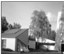
Gemeindezentrum „Hütte“ Marienberg Schulstr. 46
